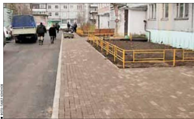
– В целом благоустройство завершено. Выполнены свод деревьев, выгорфовка, отсыпка щебнем автомобильной парковки. Установлен
